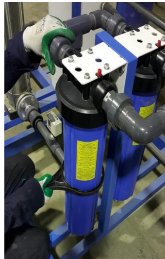
باز کردن فیلتر کارتریج با آچار مربوطه
